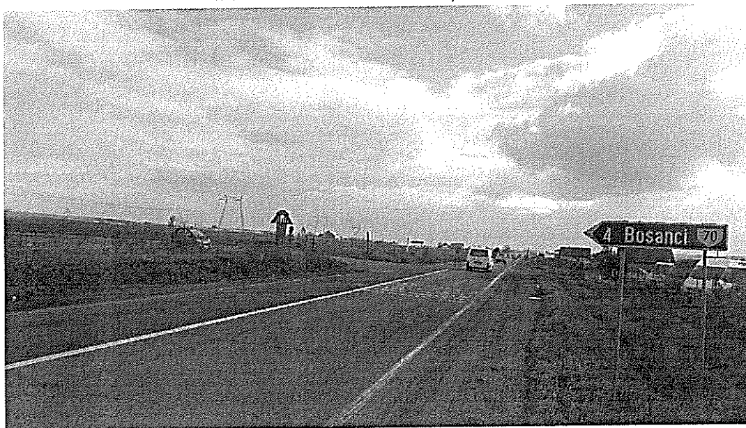
Poza 1. DN2 zona intersecției cu DC70A
